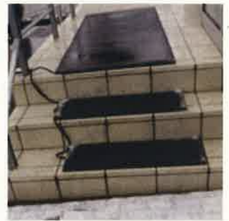
<ヒートマットの設置例>
